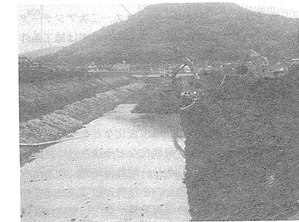
石炭鉱害事業団幹線2号水路 S.54
