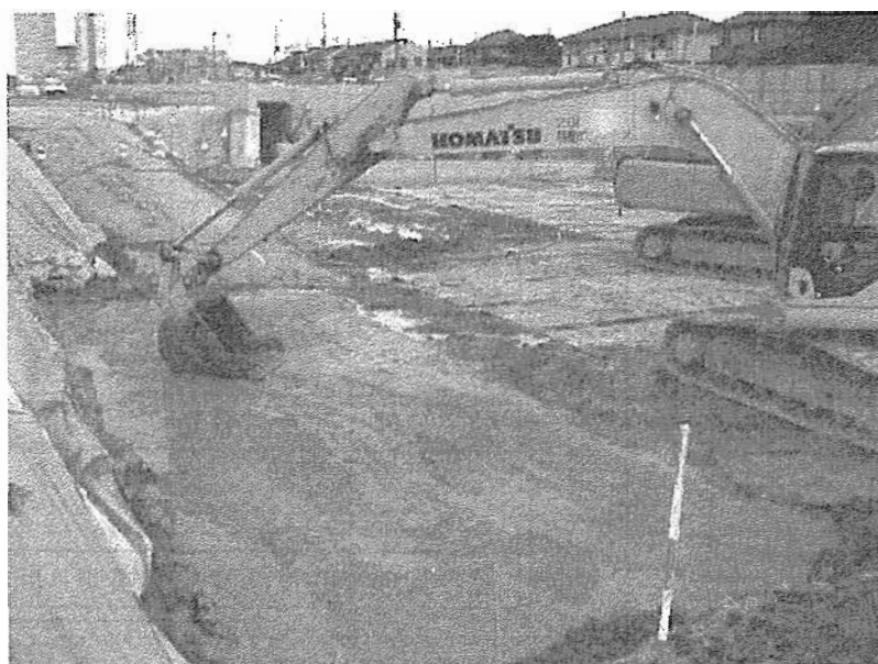
写真-3.8 修正状況
